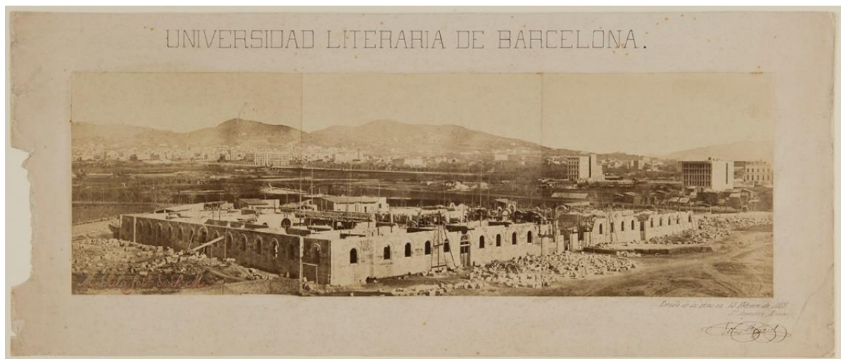
Construcció de l'Edifici Històric de la Universitat de Barcelona, 1865. AFB. Marcos Sala
