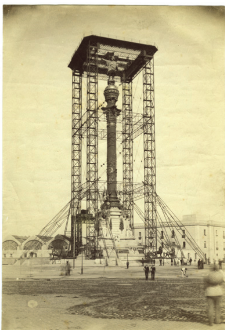
Autor desconegut - Construcció del monument a Colom, c. 1888. Arxiu fotogràfic de Barcelona
