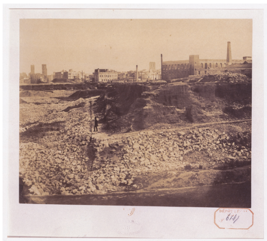
Franck (François Marie Alexandre Gobinet de Villecholes). Barcelona, demolició de les muralles , c. 1855. Bibliothèque national de France, Paris.
